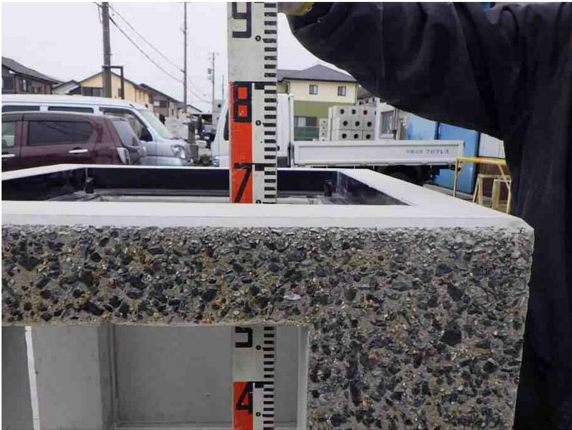
専用のシートを型枠に取付けておいてから打設し、脱型後に水洗いしました。
